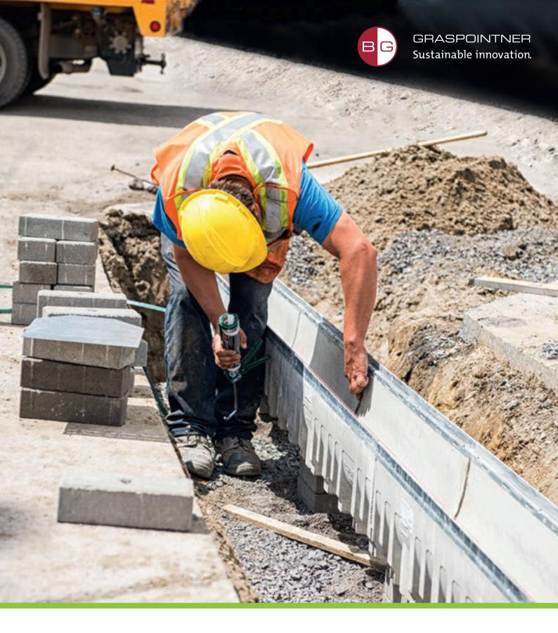
BG-Dichtsystem — anwendbar bei Rinnen mit Sicherheitsfalz
